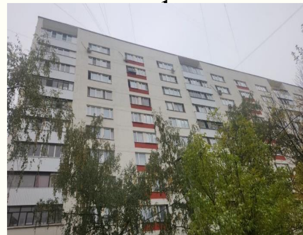
Ремонт фасада ул. Ставропольская, д. 60
